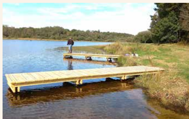
Etang du bel air à Priziac : tout juste installés, déjà utilisés
